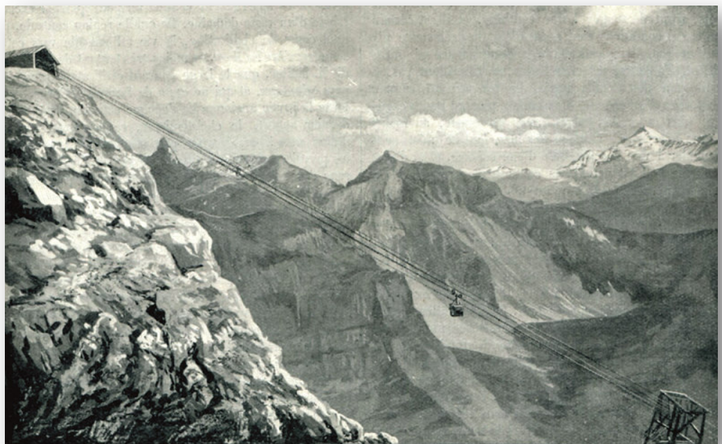
Il tratto della teleferica Chaberton in prossimità della stazione intermedia di Piano delle Marmotte
